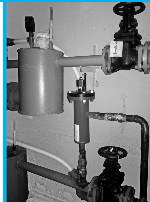
Рисунок 2. Регулятор «Комос-УЗЖ» на системе отопления
